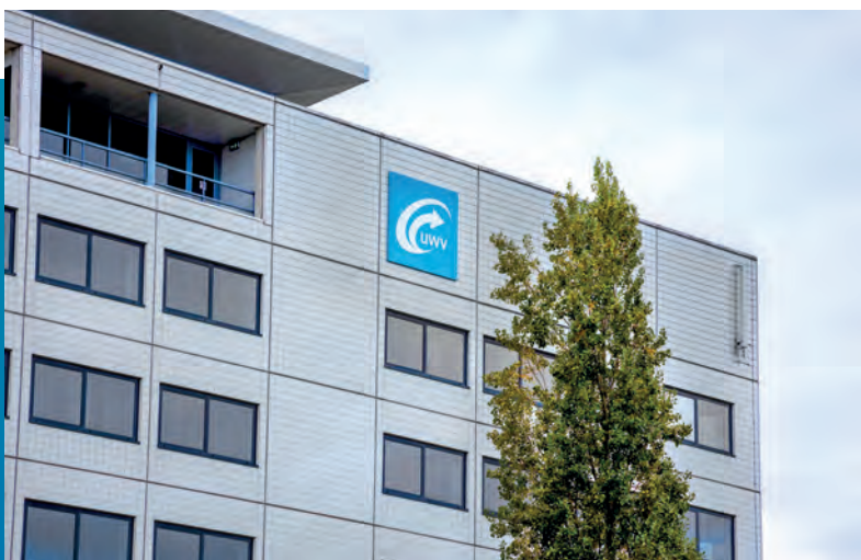
Das Gebäude der Uitvoeringsinstituut Werknemersverzekeringen (UWV) im niederländischen Venlo.
